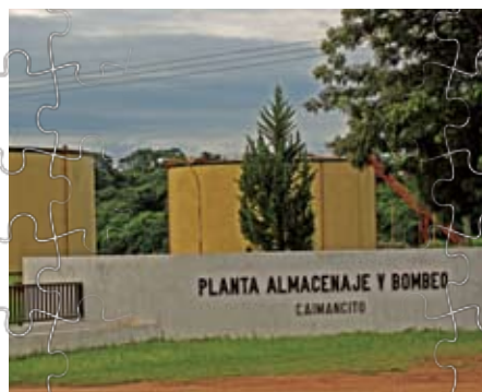
PLANTA DE ALMACENAJE Y BOMBEO DE HIDROCARBUROS, CAIMANCITO, JUJUY.
