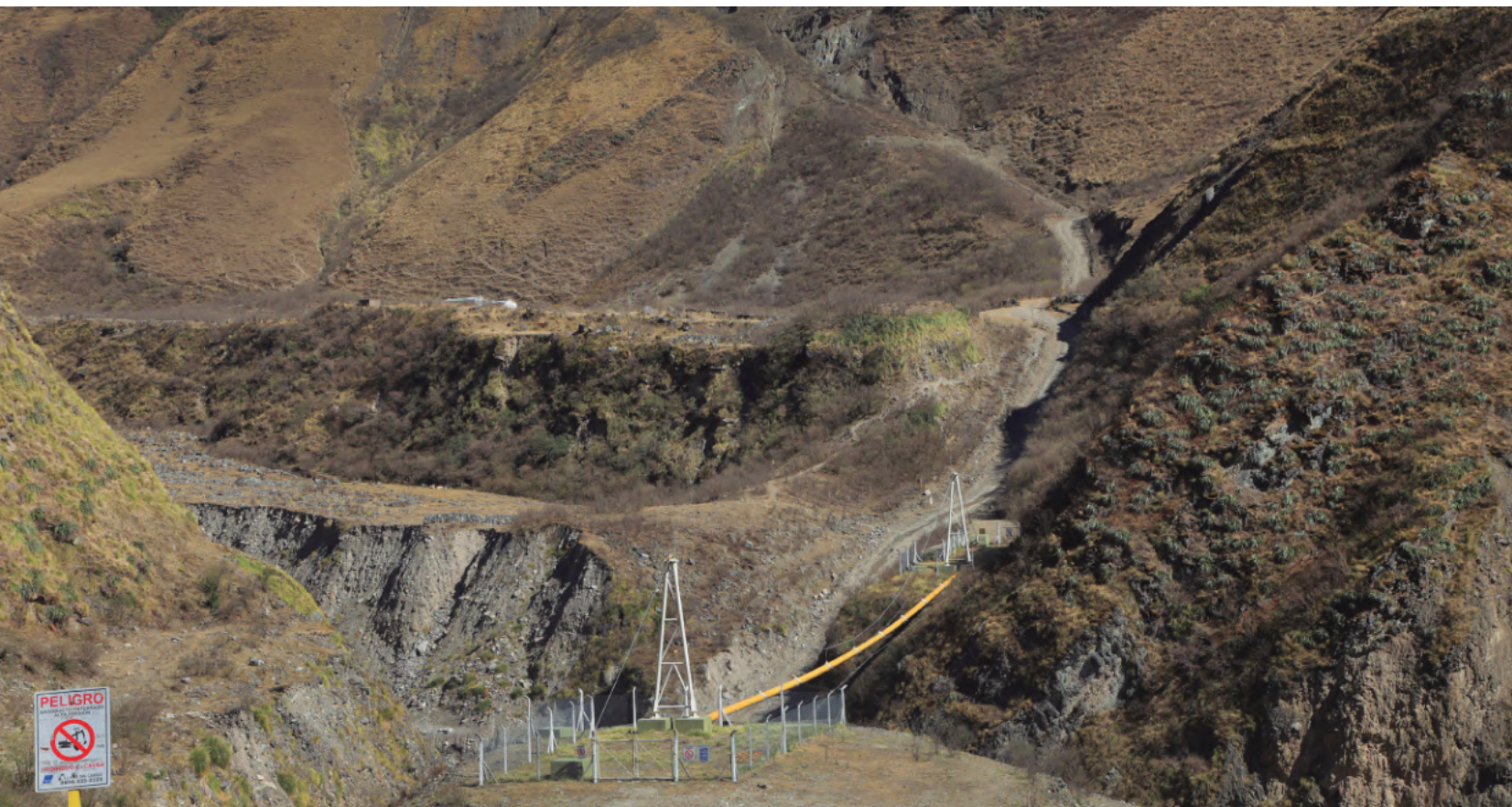
ÚNICO PASO AÉREO DEL GASODUCTO NOR ANDINO, EN CERCACÍA DE SAN ANDRÉS, SALTA. FOTO JOSÉ LUIS RODRÍGUEZ.
