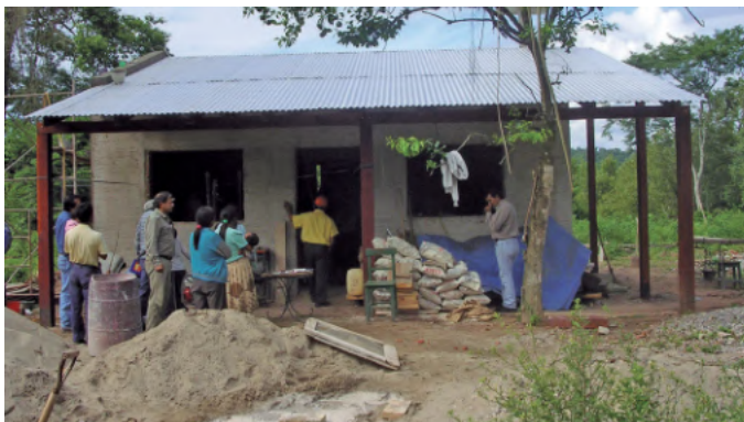
CONSTRUCCIÓN DEL PUESTO DE SALUD, EL OCULTO (SALTA) . FOTO RODRIGO ORDOÑEZ.
